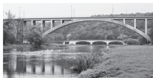
Abbildung 1: Fuldataalbrücke Bild-Quelle: Günther Pöpperl, http://regiowiki.hna.de/ Datei: Eisenbahnbruecke_baunatal_guntershausen.jpg lizenziert unter CC BY-NC-SA 2.0
